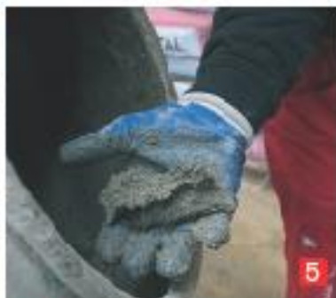
5) Verifica consistenza dell'impasto "terra umida".
