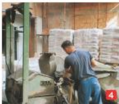
4) Preparazione impasto con impianto di pompaggio.
