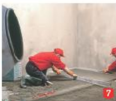
7) Realizzazione delle fasce di livello.
