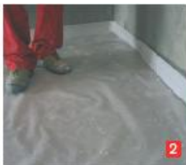
2) Applicazione di materiale espanso lungo i perimetri dei locali e nei punti di vincolo. Stesura di un telo di polietilene in caso di massetti desolidarizzati.
