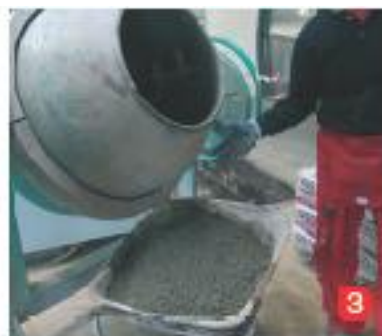
3) Preparazione impasto in betoniera.
