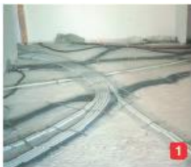
1) Applicazione preventiva di una rete metallica leggera sui passaggi di tubi e guaine.
